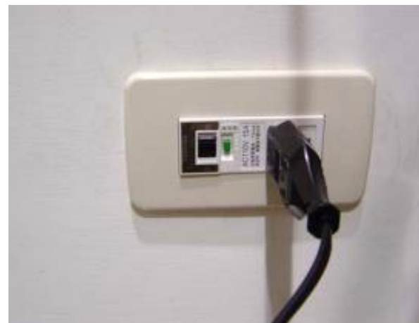
固定型漏電斷路器
