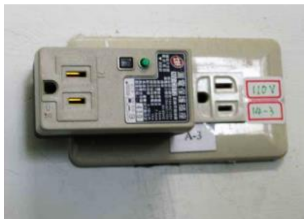
外接式漏電斷路器
